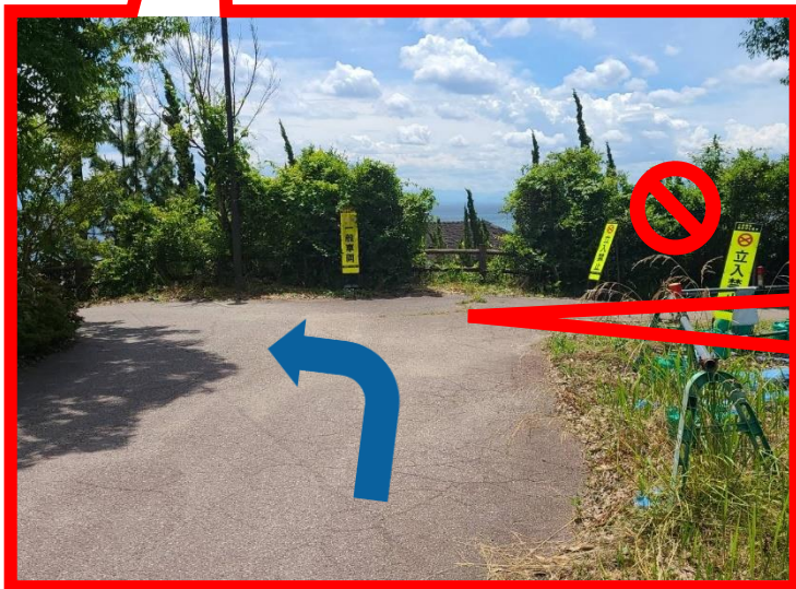
◆右側が工事中のため、一般車両は通行できません。
